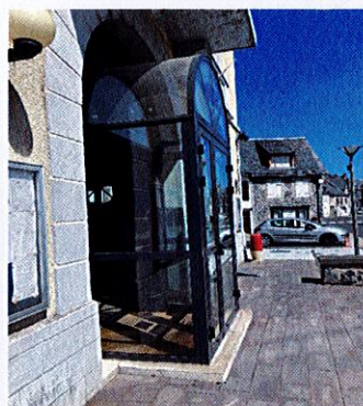
Le remplacement du SAS de l'entrée de la Mairie
